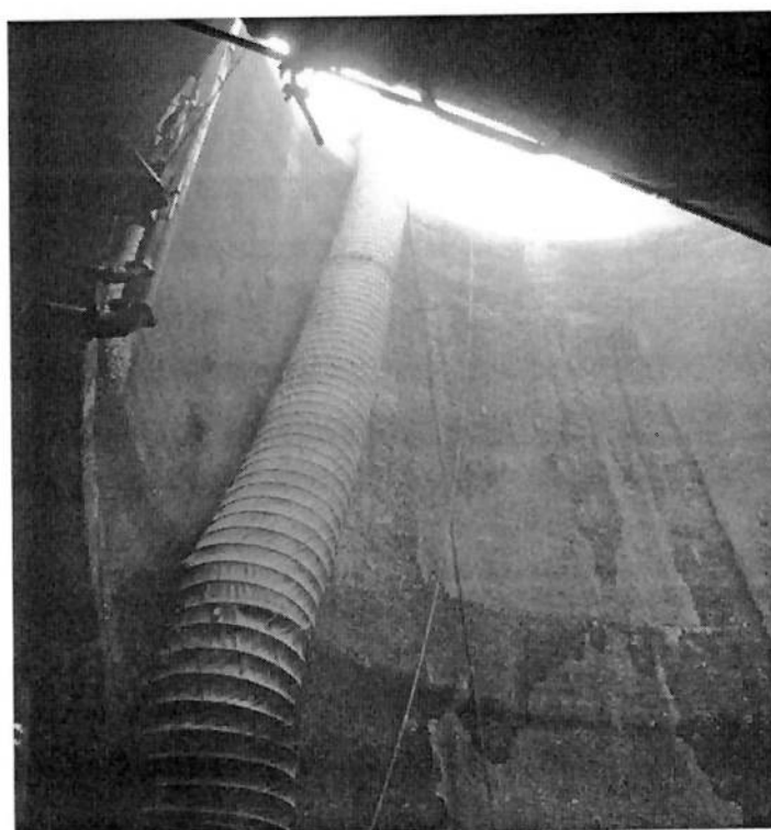
Figura 9 – Foto do tubo de ventilação
