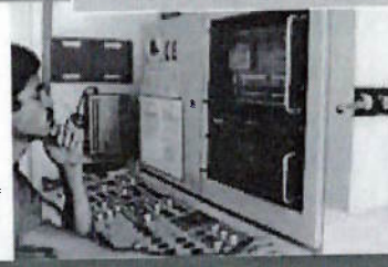
Equipamento de monitoração remota da cravação
