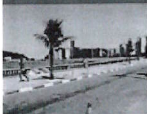
Vista da superfície com Pipe jacking em execução
