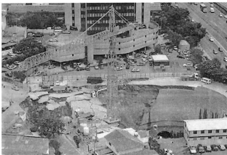
Figura 4 – Foto da localização da grua
