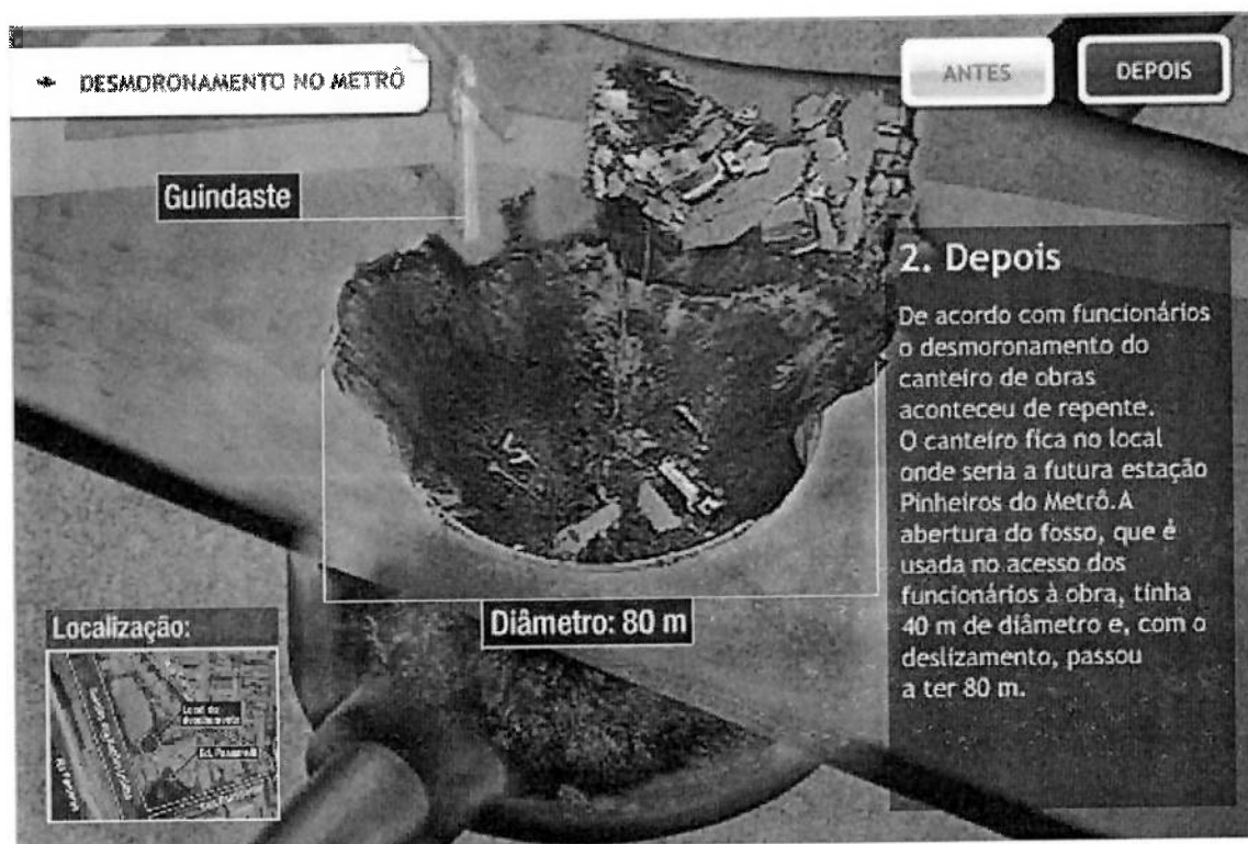
Figura 20 – Depois do desmoronamento
