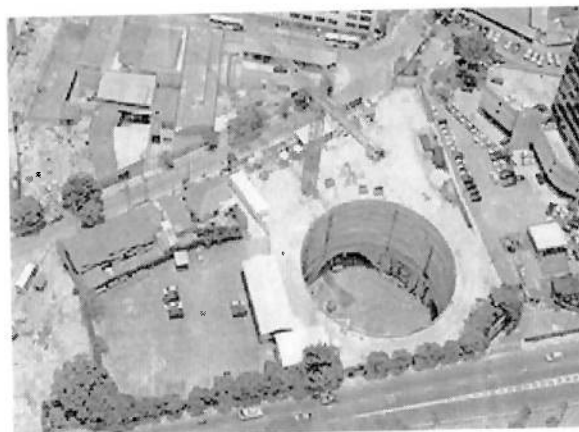
Figura 2 - Vista aérea antes do colapso
