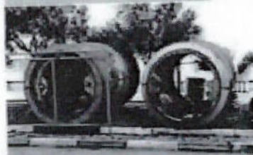
Câmara de Shield aguardando montagem
