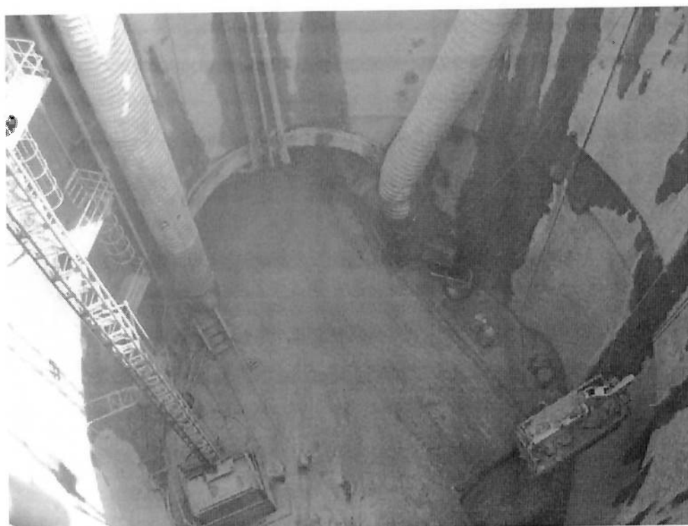
Figura 8 – Foto do túnel de visita
